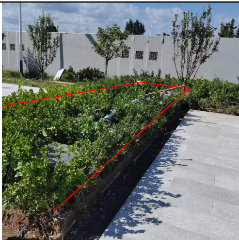
地埋式污水处理站
