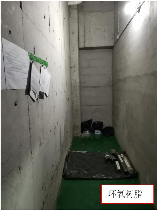
危废间内部（环氧树脂地面）
