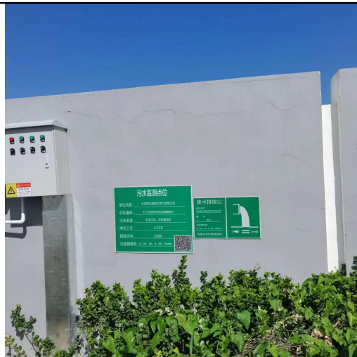
厂区废水总排口
